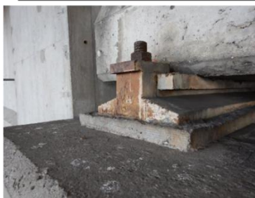
変状データ：高架橋支承部の腐食
