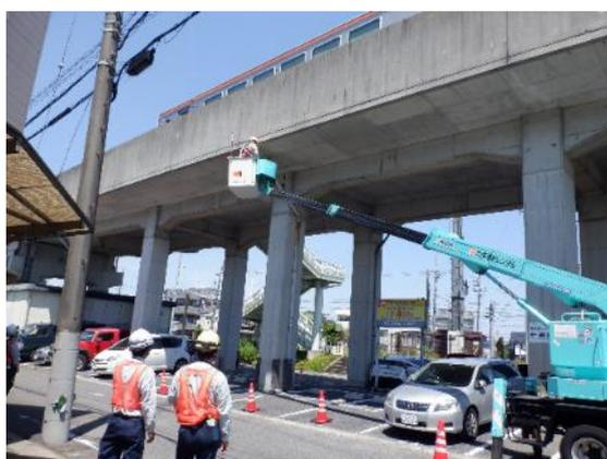
高所作業車を使用した打音点検の様子
